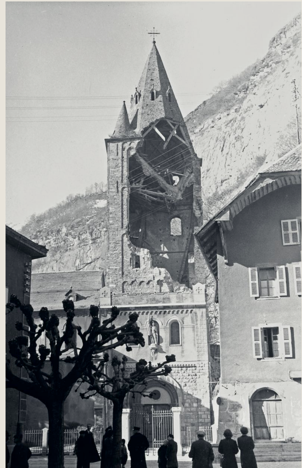
← Le 3 mars 1942 à 7h50, un bloc de rocher se détache de la falaise et s'écrase sur le clocher de l'église abbatiale. Les curieux accourent pour contempler les dégâts.
