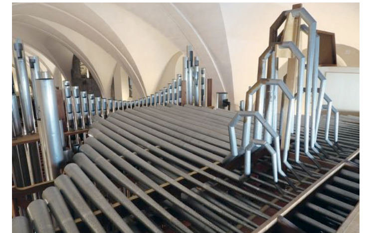
↑ Fig. 1 : Les chamades installées sur le toit de l'orgue en 1951. Il s'agit des tuyaux horizontaux qui ajoutent un éclat de fanfare à l'ensemble de l'instrument (archives Kuhn).
