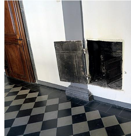
Dans les corridors de l'Abbaye, des ouvertures permettent d'accéder aux fourneaux, presque tous en pierre ollaire, encastrés dans les murs pour chauffer deux chambres à la fois. Les cheminées servent aujourd'hui au passage des conduites d'eau.
