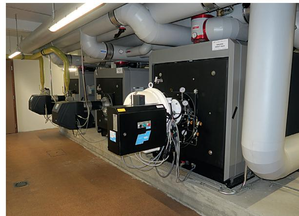
Les nouvelles installations. En haut la station de traitement de l'eau. Puis les quatre pompes à chaleur. Et tout en bas les deux chaudières à gaz et la chaudière à mazout de secours.
