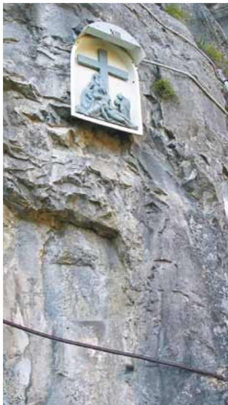
L'emplacement des anciennes stations du chemin de croix est encore visibles en plusieurs places.
