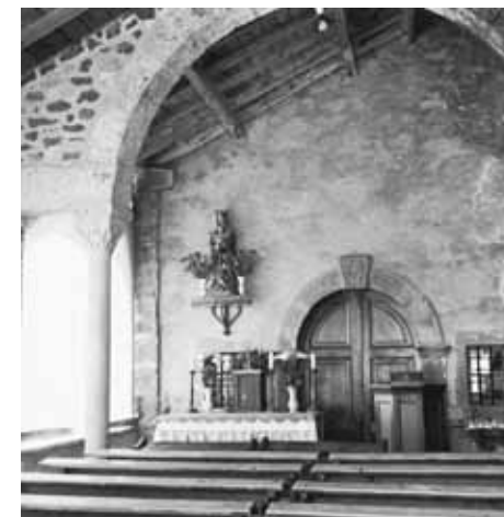
Pendant les travaux, on a célébré la messe à l'extérieur, sous le porche.
