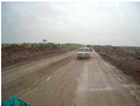
Conditions de circulation difficiles par temps de pluie.
