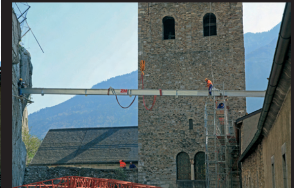
En haut, suspendus dans la falaise, les spécialistes guident les foreuses qui percent les trous nécessaires aux ancrages des haubans dans le rocher. Dessous, les invités placés sur une petite vire de rocher près du tunnel des CFF assistent à l'arrivée et à la mise en place de la première poutre de la couverture.
