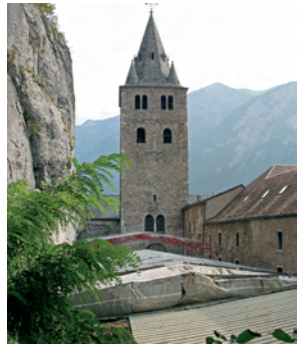
Le Martolet avant les travaux.
