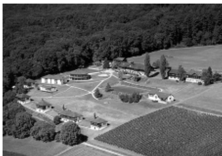
Vue aérienne du Camp de Vaumarcus.
