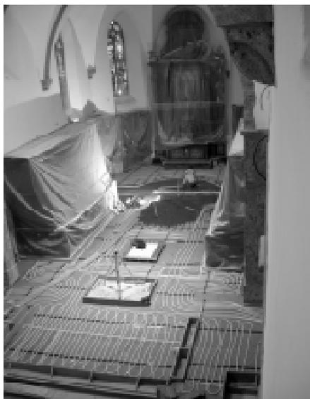
*On a profité du chantier pour installer dans le chœur un chauffage par le sol.*
