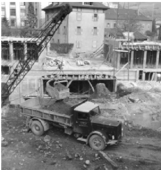
Pendant les travaux d'excavation, on devine déjà la scène de la Grande Salle du Collège.
