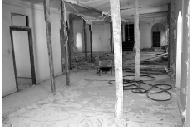
La première étape du chantier de la nouvelle salle capitulaire a consisté à la démolition. Ici, à l'étage du noviciat.
