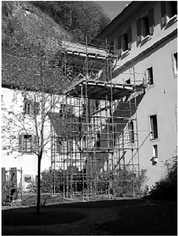
La quiétude de la cour Saint-Théodule est troublée par le grand chantier de la future salle capitulaire.
