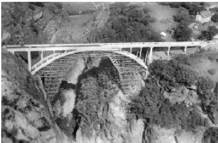
Le fameux pont du Gueuroz a été construit en 1934 sur une armature en bois. Cet impressionnant cintre fut monté par l'entreprise de charpente Richard Coray, des Grisons.
